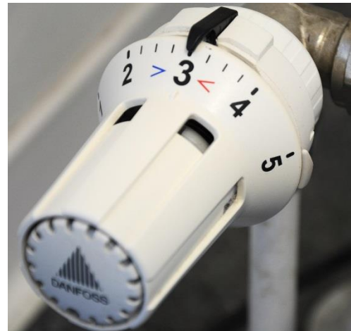
Thermostatventil zur Regelung der Raumtemperatur
