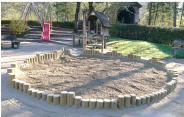
Sandkastenumrandung erneuert und Sand ausgetauscht
