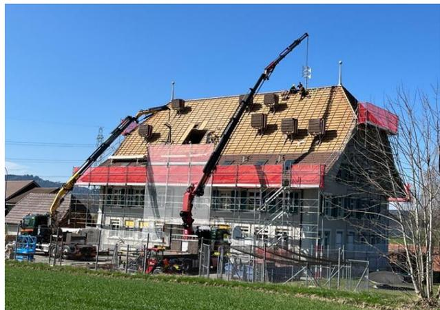
Kranarbeiten Dachausdeckung und Versetzen der Sirene
